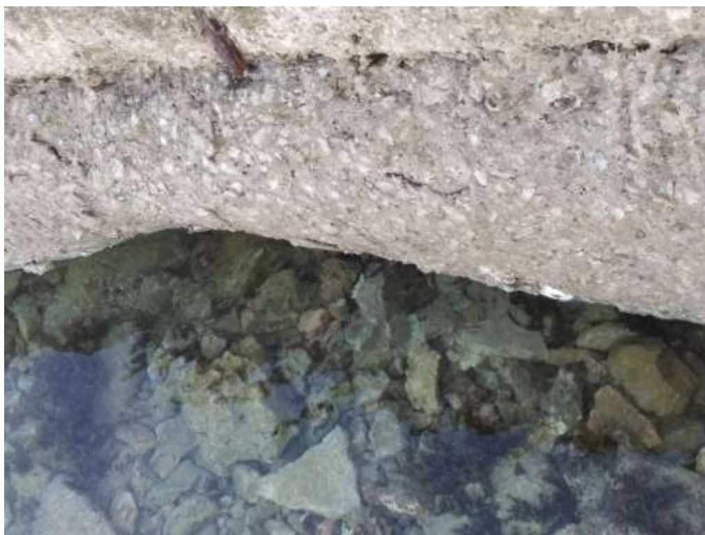
Slika 4. i 5. Podlokani obalni zid
