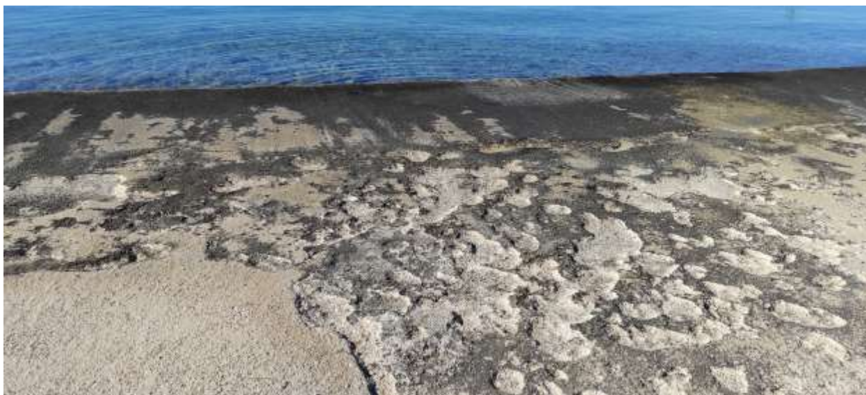
Slika 2. i 3. Oštećeni obalni plato
